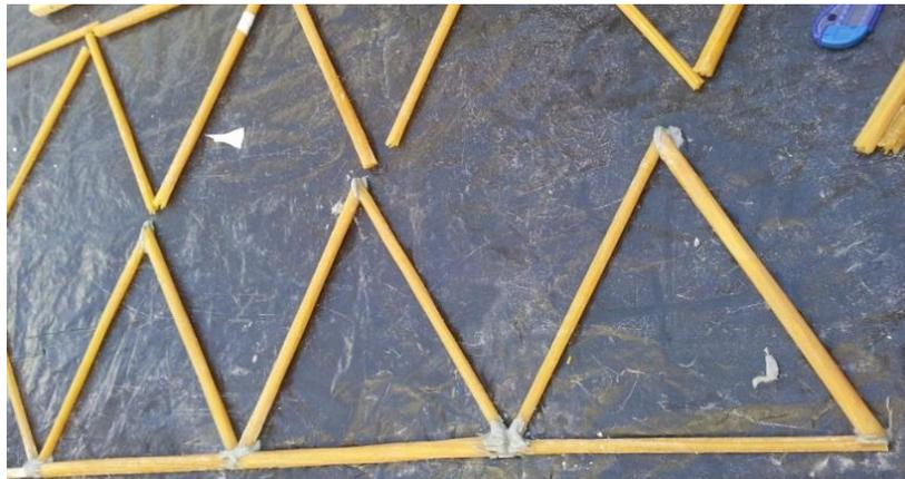
**Figura 2 – Construção das hastes da ponte secando para a montagem.**
