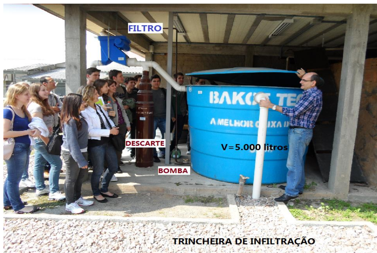
Figura 3 - Captação e armazenamento da água de chuva e a trincheira de infiltração.
