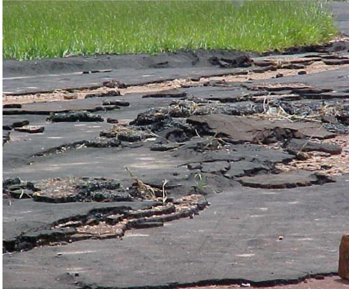
Figura 5: Pavimento deteriorado. Fonte: Cordeiro – arquivo próprio.
